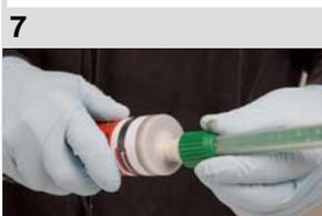
**Statikmischer aufsetzen und mit Überwurfmutter anschrauben.**
